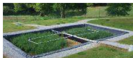
2 ème étage d'un filtre Rhizostep® Source : SATESE 56
