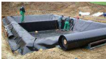
Pose de la géomembrane
