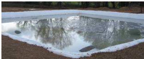
Test d'étanchéité (mise en eau du bassin)
